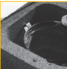
14. Обильно нанесите герметик Rotempo на верхнюю кромку керамической трубы.
