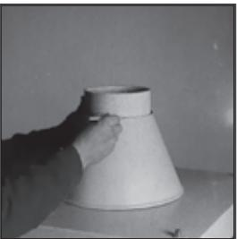
43. Вставьте внутрь керамическую трубу, установите конус и измерьте длину последнего керамического элемента, отметив линию по верхнему краю конуса.
