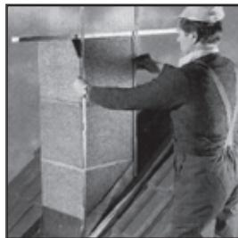
37. Наложите рейки толщиной около 3 см на верхнюю часть готовой каменной оболочки дымовой трубы и снимите требуемые размеры до выполненной конструкции крыши.
