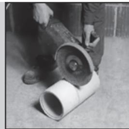
44. Обрежьте керамическую трубу угловой шлифовальной машиной, после чего очистите оба конца трубы от пыли. Обильно нанесите на трубу герметик Rotempo и установите её на место.
