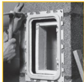
29. Снимите дверцу с рамки. Выровняйте рамку дверцы относительно рамки керамического тройника и прикрутите саморезами к блокам.
