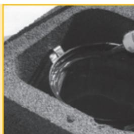
8. Нанесите на верхнюю кромку ёмкости для сбора и отвода конденсата достаточное количество герметика Rotempo. Температура монтажа должна быть  $\geq 5^{\circ}\text{C}$
