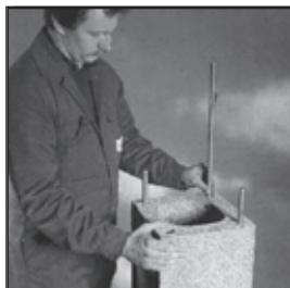
34. Вставьте арматурные стержни в специальные каналы. Упоры на арматурных стержнях с резьбой не позволяют им проваливаться внутрь. Количество стержней определяется проектом.
