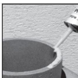
45. На верхний край керамической трубы нанесите герметик Rotempo и установите конус.
